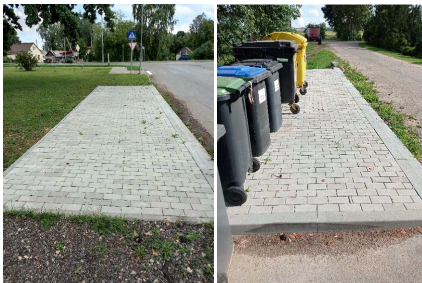
Pav. 5 Šiaulių r. savivaldybės teritorijoje antžeminės atliekų surinkimo konteinerių aikštelės
