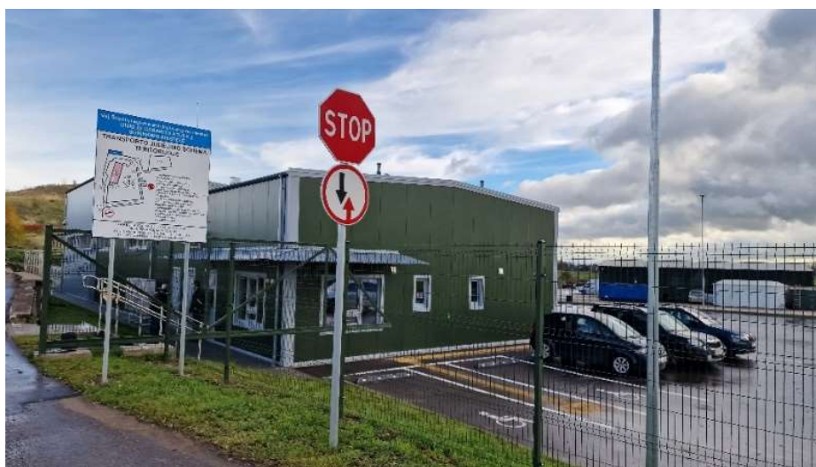
Pav. 7 Kairių didelių gabaritų atliekų surinkimo aikštelė, kurioje įrengta atliekų (daiktų) paruošimo naudoti pakartotinai infrastruktūra
