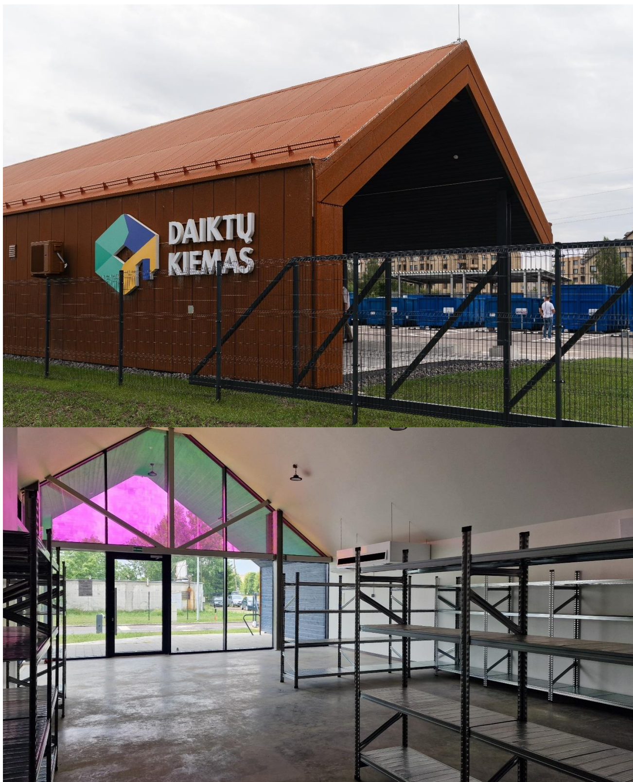
Pav. 5 2024 m. pastatyta Šiaulių m. (S. Dariaus ir S. Girėno g.) didelių gabaritų atliekų surinkimo aikštelė, kurioje įrengta atliekų (daiktų) paruošimo naudoti pakartotinai infrastruktūra
