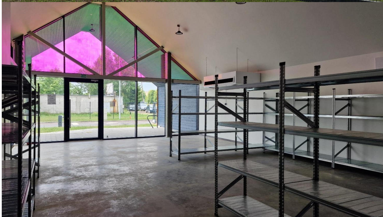
Pav. 5 2024 m. pastatyta Šiaulių m. (S. Dariaus ir S. Girėno g.) didelių gabaritų atliekų surinkimo aikštelė, kurioje įrengta atliekų (daiktų) paruošimo naudoti pakartotinai infrastruktūra
