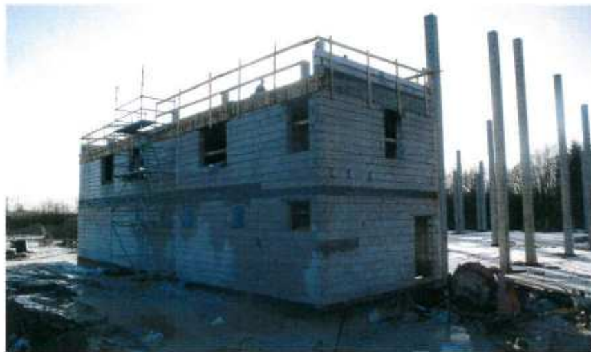
Operatorinės, personalo ir buitinių patalpų statyba
