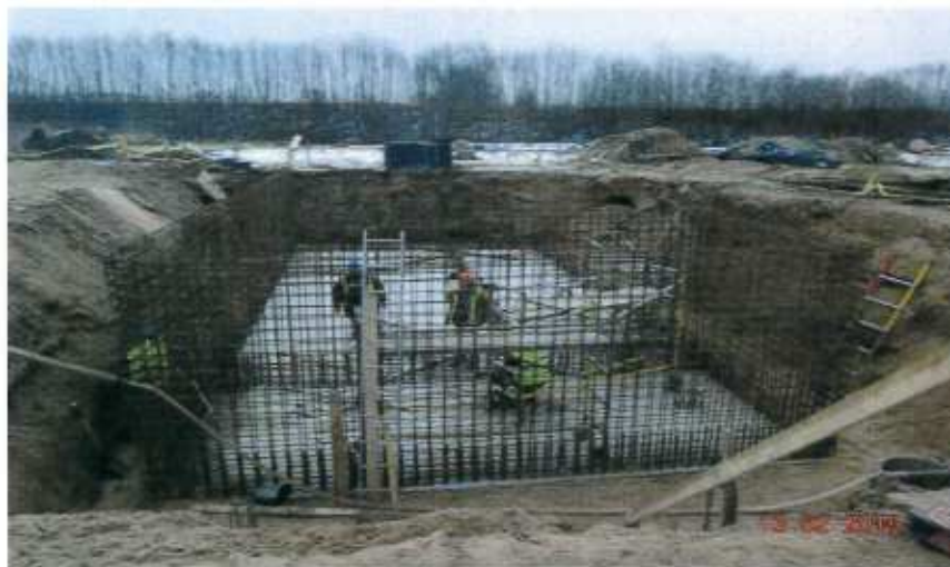
Ventiliatorinės ir techninių nuotekų rezervuaro statyba
