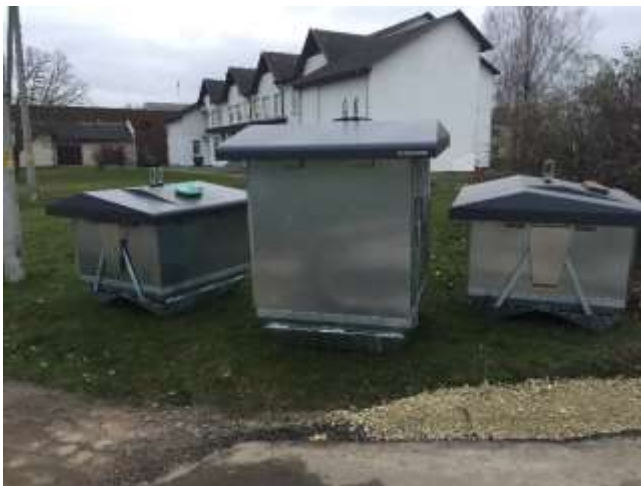
2 pav. Joniškyje įrengtos pusiau požeminės konteinerių stovėjimo aikštelės su betonine šachta ir metaline atliekų kaupykla, apdaila – nerūdijantis perforuotas plienas
