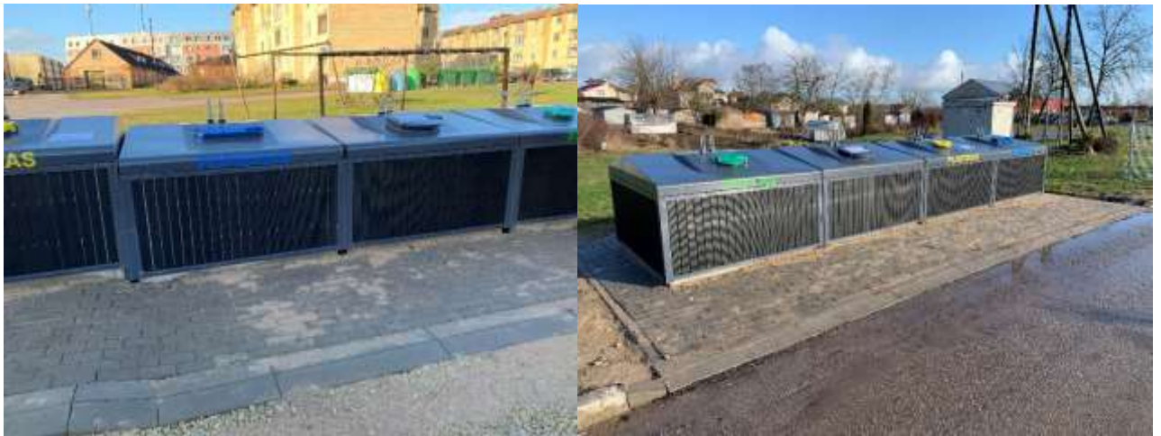
4 pav. Šiaulių rajono savivaldybės teritorijoje įrengiamos pusiau požeminės konteinerių stovėjimo aikštelės su betonine atliekų šachta ir metaline atliekų kaupykla, apdaila – plastikinė
