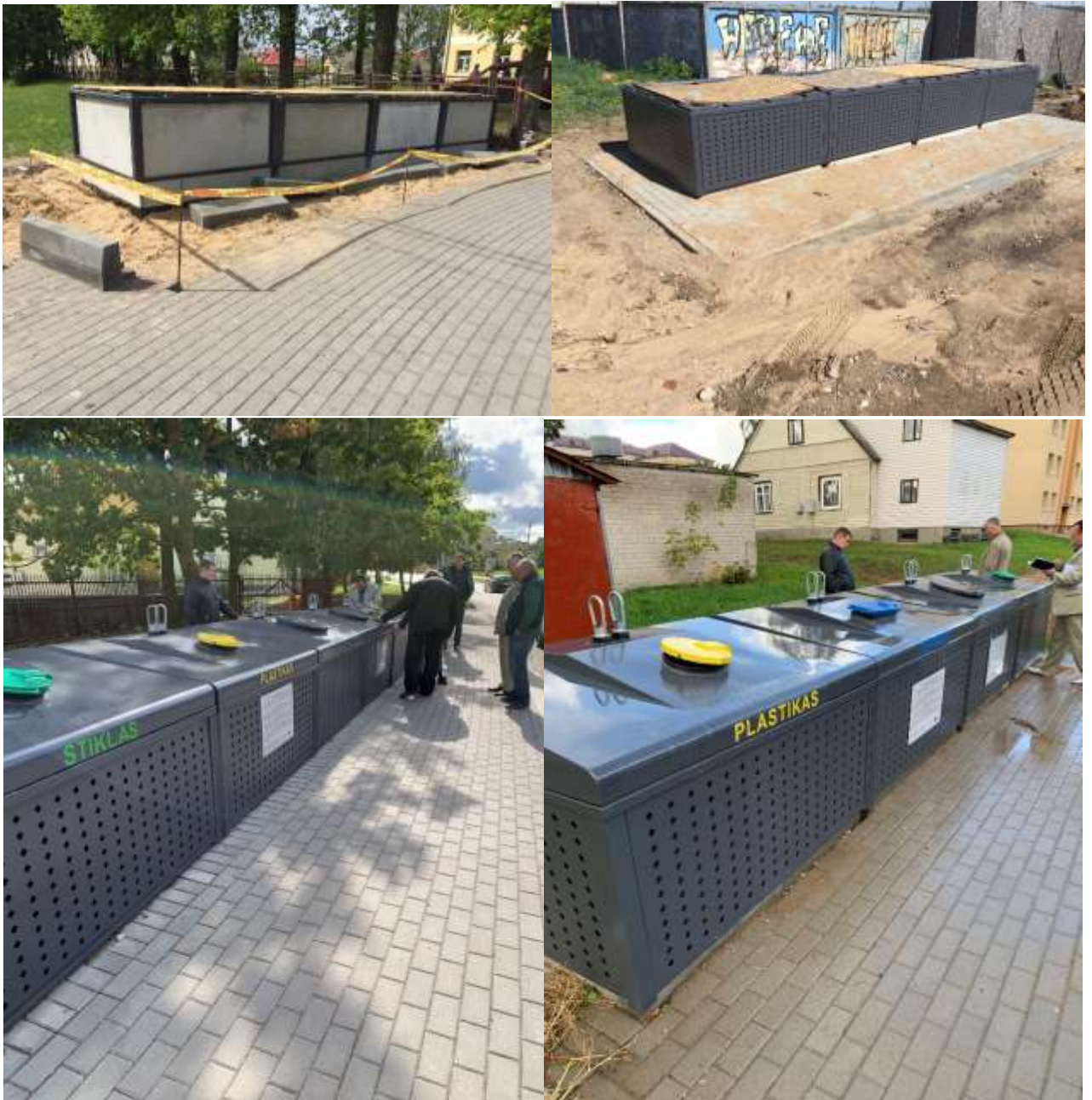
3 pav. Kelmės rajono savivaldybės teritorijoje įrengiamos pusiau požeminės konteinerių stovėjimo aikštelės su betonine atliekų šachta ir metaline atliekų kaupykla, apdaila – metalinė
