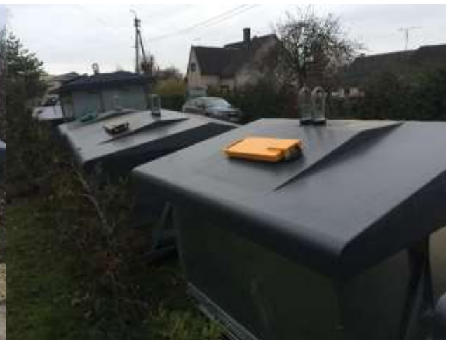
2 pav. Joniškyje įrengtos pusiau požeminės konteinerių stovėjimo aikštelės su betonine šachta ir metaline atliekų kaupykla, apdaila – nerūdijantis perforuotas plienas
