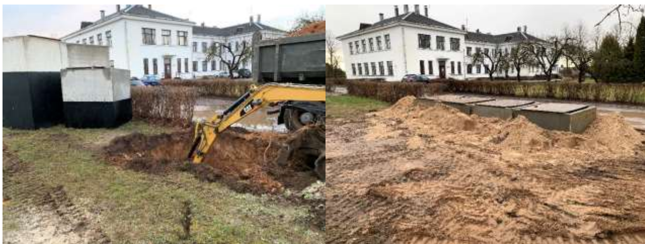
1 pav. Pusiau požeminių konteinerių aikštelių įrengimo darbai – įkasamos betoninės atliekų šachtos, į kurias vėliau bus įleidžiamos metalinės atliekų kaupyklos. Suplanuota apdaila – metalinė
