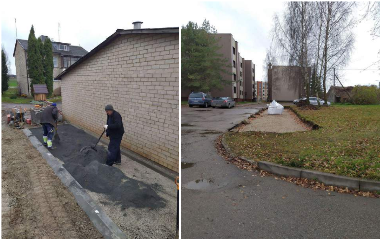
1 pav. Pakruojo r. savivaldybės teritorijoje antžeminių konteinerių aikštelių rangos darbai
