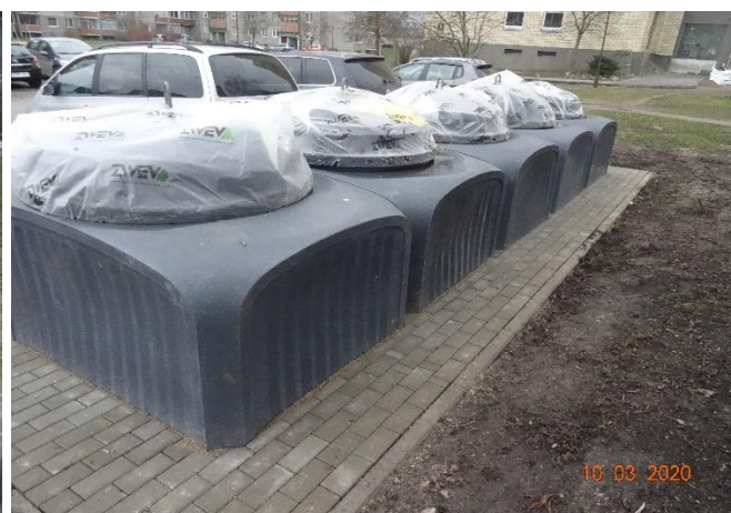
5 pav. Šiaulių m. savivaldybės teritorijoje pusiau požeminių atliekų surinkimo konteinerių aikštelių įrengimas
