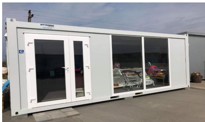
8 pav. Daiktų dalijimosi punktų „Daiktų kiemas“ namelių montavimo darbai
