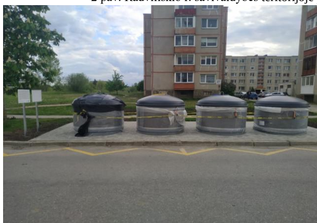
2 pav. Radviliškio r. savivaldybės teritorijoje pusiau požeminių atliekų surinkimo konteinerių montavimas
