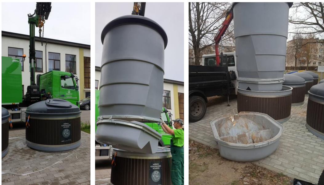
2 pav. Radviliškio r. savivaldybės teritorijoje pusiau požeminių atliekų surinkimo konteinerių montavimas
