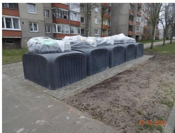
5 pav. Šiaulių m. savivaldybės teritorijoje pusiau požeminių atliekų surinkimo konteinerių aikštelių įrengimas
