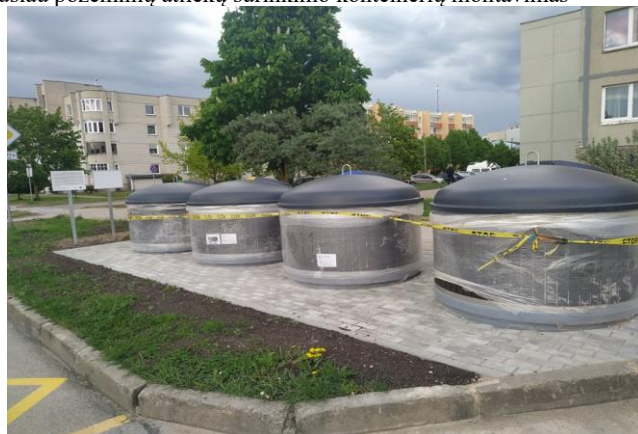
2 pav. Radviliškio r. savivaldybės teritorijoje pusiau požeminių atliekų surinkimo konteinerių montavimas
