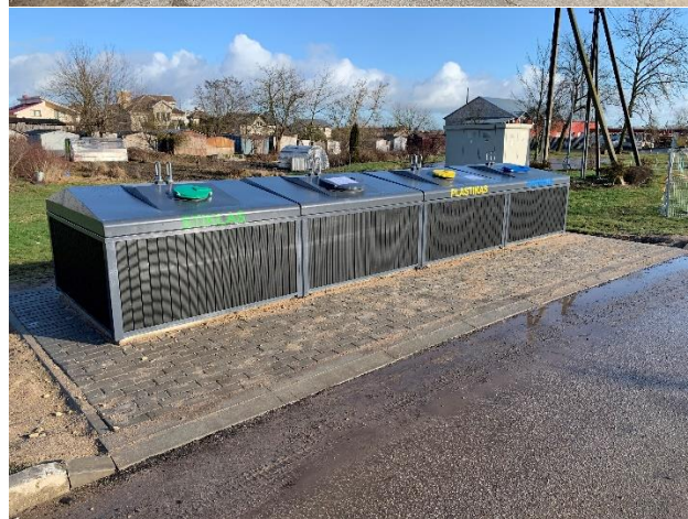
4 pav. Šiaulių r. savivaldybėje pusiau požeminių atliekų surinkimo konteinerių aikštelių įrengimas
